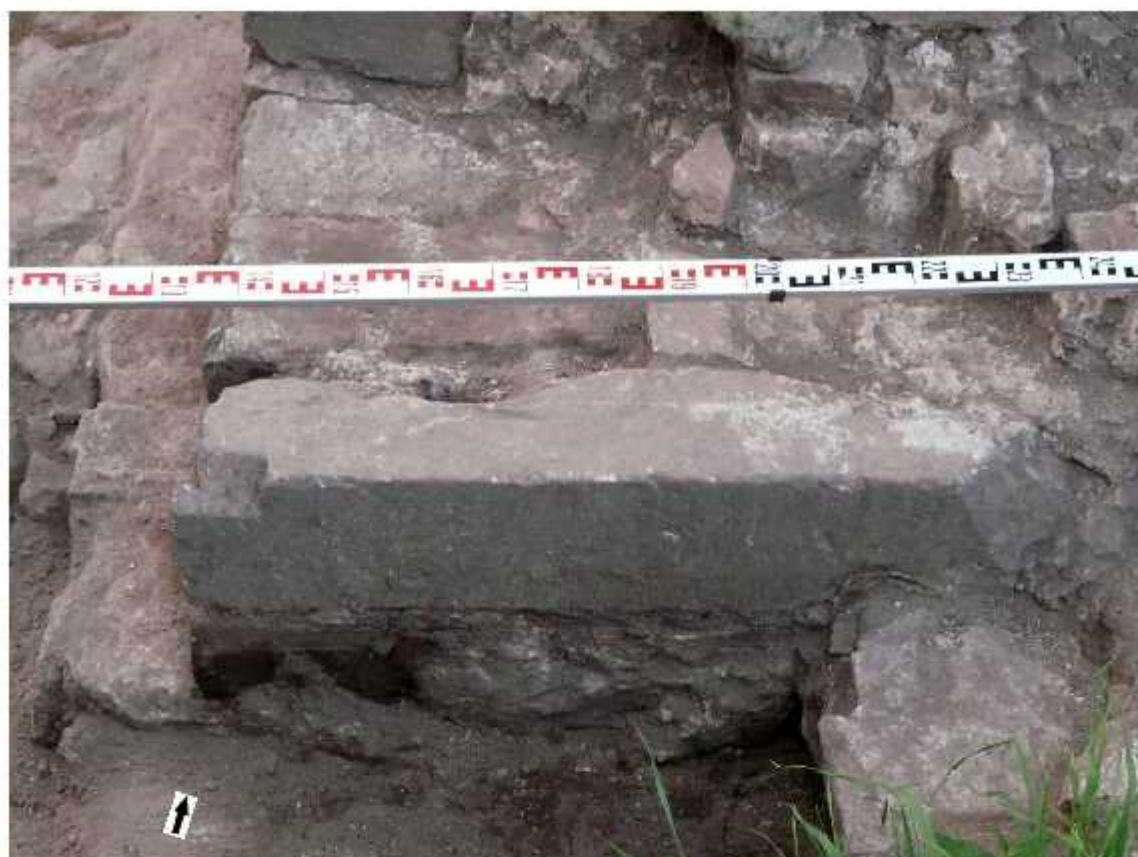
Fot. 52. Bodzentyń, zamek, teren pałacu biskupów krakowskich. Wykop 2/2019, odcinek I, część zachodnia. Fragment detalu architektonicznego (obramienia otworu) wtórnie użyty do wyrównania cokołu pod naroże SW skrzydła N pałacu. Widok od S.
