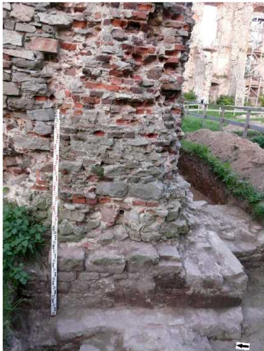
Fot. 50. Bodzentyn, zamek, teren pałacu biskupów krakowskich. Wykop 2/2019, odcinek I, część zachodnia. Relikty ściany W średniowiecznej wieży, naroża SW skrzydła N pałacu oraz muru E Widok od W.
