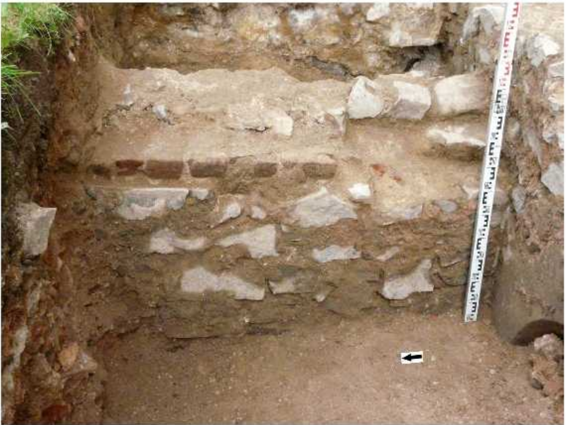
Fot. 35. Bodzentyn, zamek, teren pałacu biskupów krakowskich. Wykop 1/2019, odcinek II, część wschodnia. Lico zachodnie i korona muru A z częściowo zachowanym ceglany oporem sklepienia. Widok od W.
