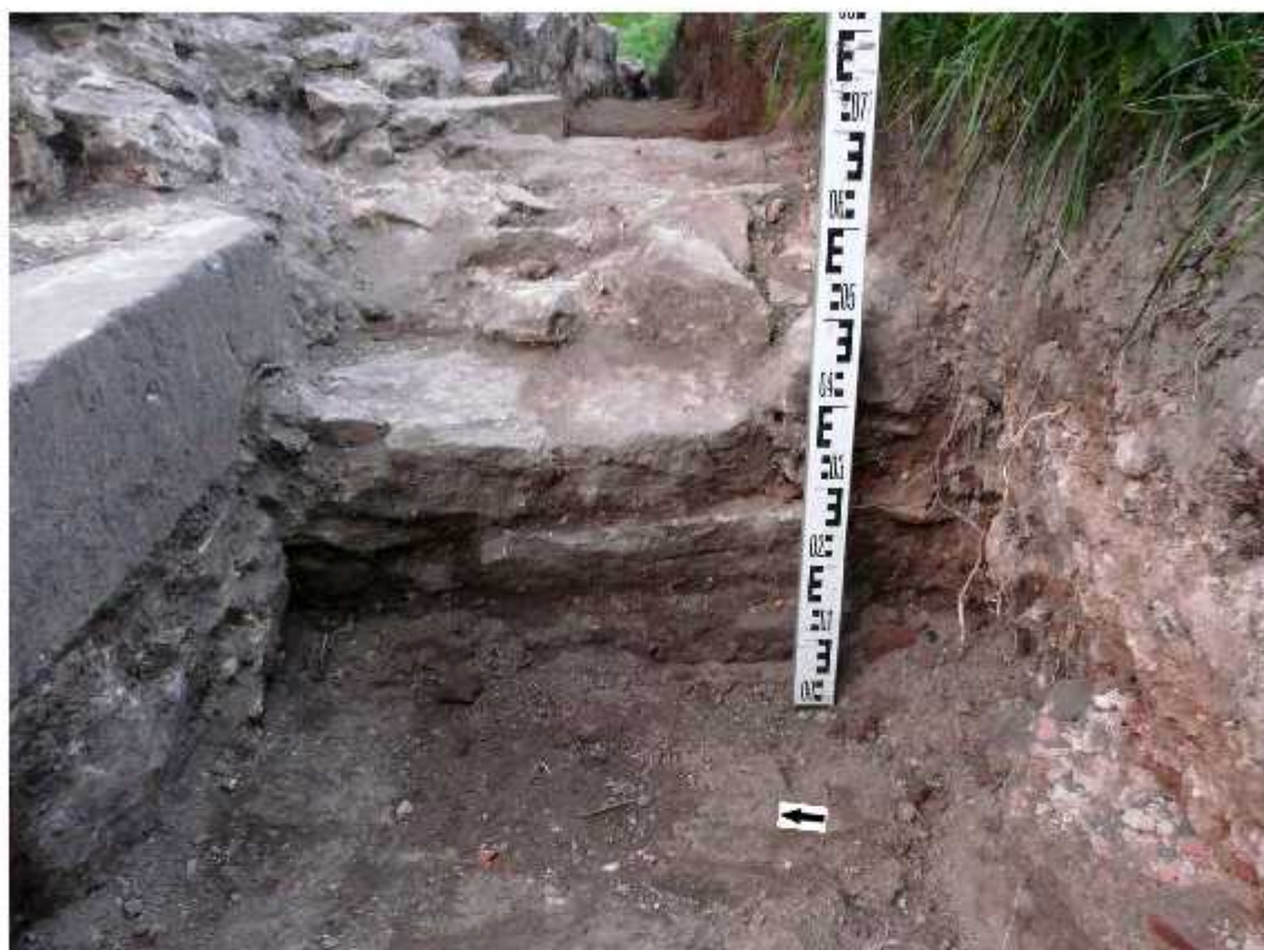
Fot. 54. Bodzentyn, zamek, teren pałacu biskupów krakowskich. Wykop 2/2019, odcinek I, część zachodnia. Lico zachodnie muru D na styku z oblicowaniem ściany S średniowiecznej wieży (węzeł przewiązany). Widok od W.
