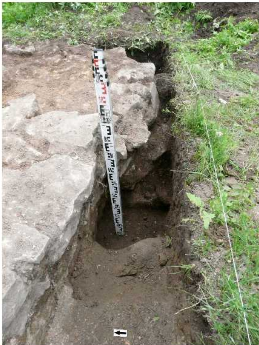
Fot. 17. Bodzentyn, zamek, teren pałacu biskupów krakowskich. Wykop 2/2019, odc. 1, część wschodnia w trakcie eksploracji. Narożcie SE średniowiecznej wieży w obrębie cokołu ściany S skrzydła N pałacu oraz północny kraniec muru B. Widok od W.
