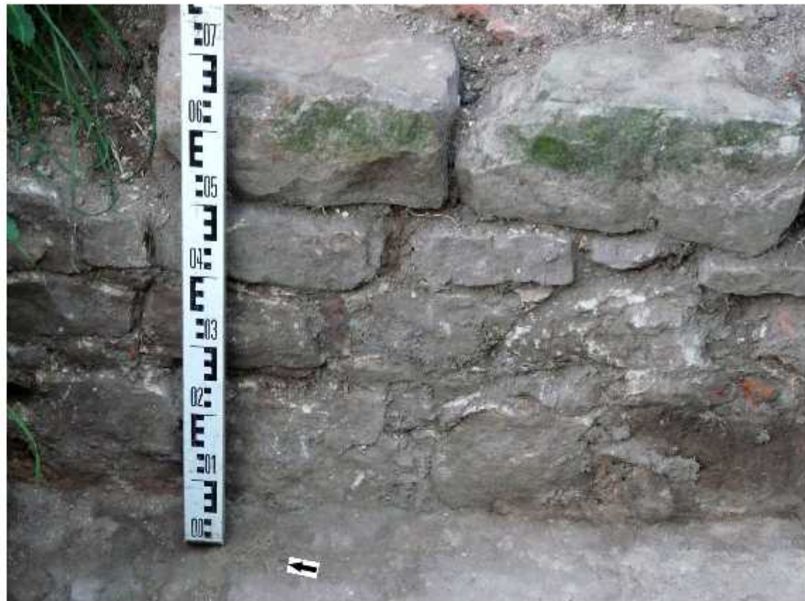
Fot. 51. Bodzentyn, zamek, teren pałacu biskupów krakowskich. Wykop 2/2019, odcinek I, część zachodnia. Fragment oblicowania ściany W średniowiecznej wieży. idok od W.
