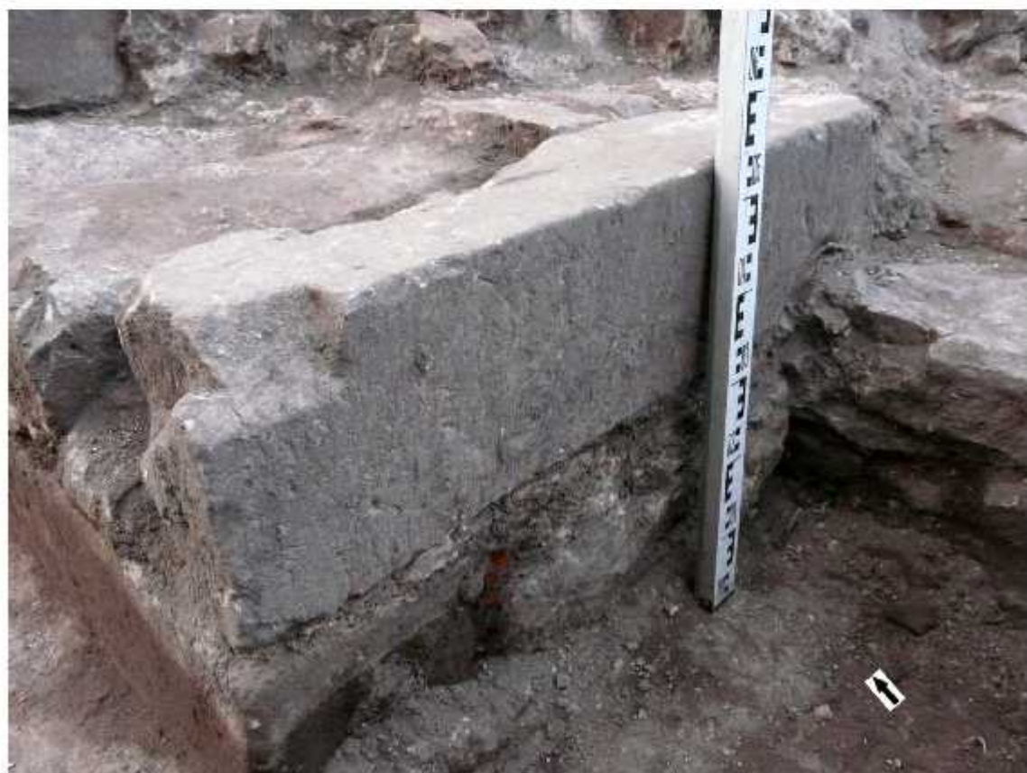
Fot. 53. Bodzentyń, zamek, teren pałacu biskupów krakowskich. Wykop 2/2019, odcinek I, część zachodnia. Fragment detalu architektonicznego (obramienia otworu) wtórnie użyty do wyrównania cokołu pod naroże SW skrzydła N pałacu. Widok od SW.
