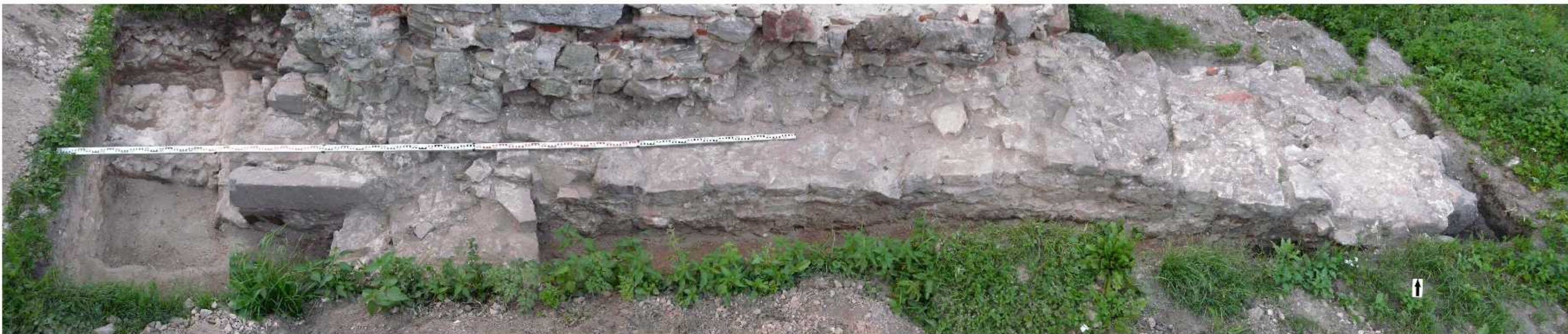
Fot. 46. Bodzentyn, zamek, teren pałacu biskupów krakowskich. Wykop 2/2019, odcinek I. Widok ogólny odcinka od S.
